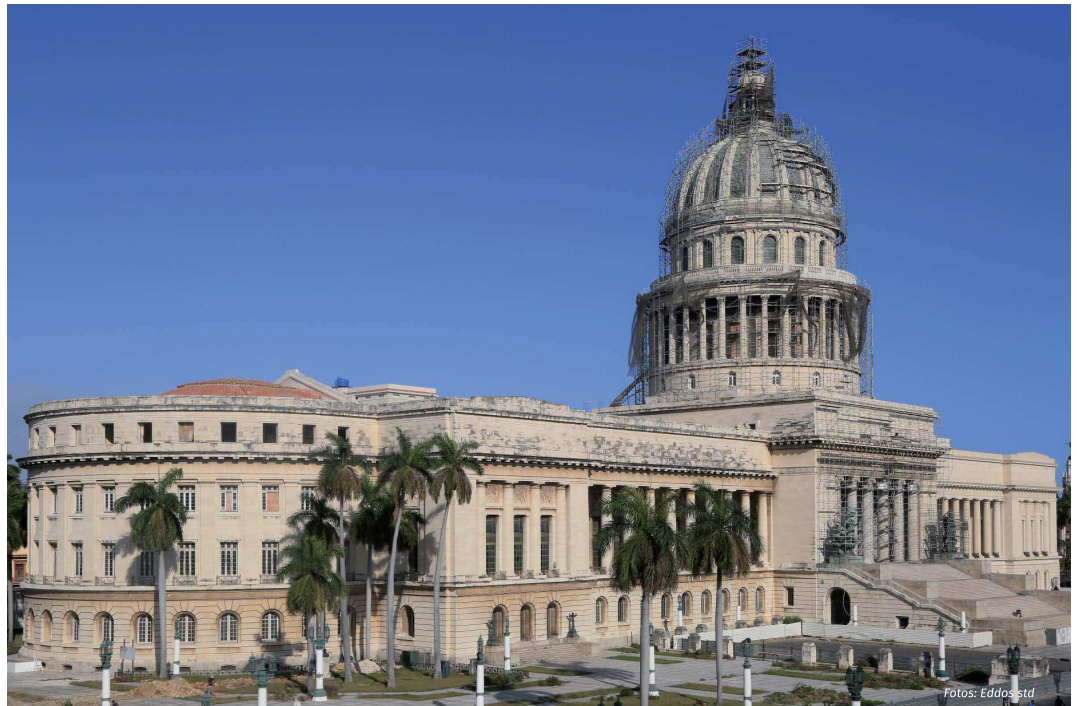
Das Kapitol in Havanna während der Restaurierung.
